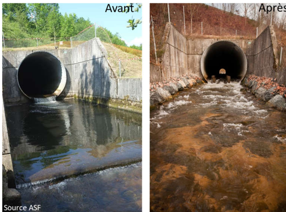
Planche photographique 1 : Vue aval de la buse, avant (à gauche) et après (à droite) les travaux. Source ASF.
