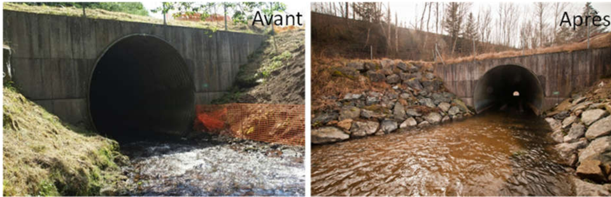
Planche photographique 2 : Vue amont de la buse, avant (à gauche) et après (à droite) les travaux. Source ASF.
