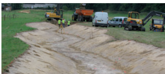
Réouverture de l'ancien lit et reméandrage léger. Été 2010
