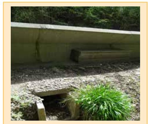
Ci-dessus : Au premier plan : sortie du tube de montée. Derrière : entrée du tube de descente. Noter le bas-volet (surplomb)
