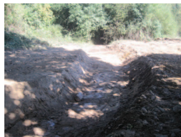
Reprofilage des berges et du fond du lit
