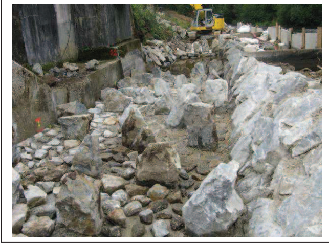
Mise en place des petits blocs dans le fond afin d'assurer la rugosité de l'ouvrage
