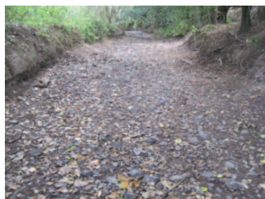
Vue sur bras de décharge du Moulin
