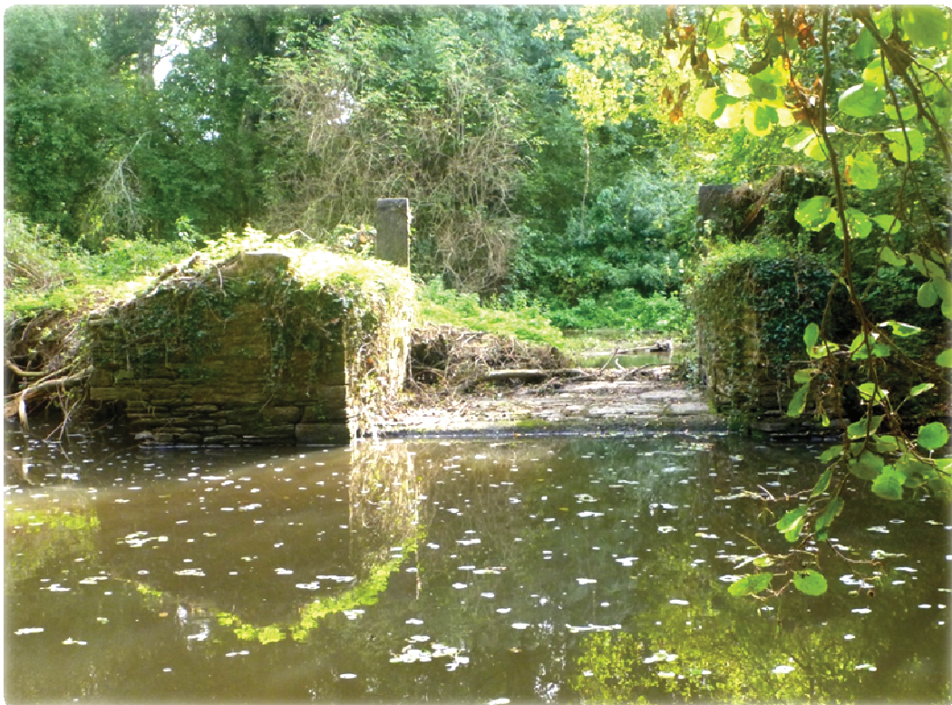
Après travaux vanne n°1 suppression des parties mobiles en bois :
