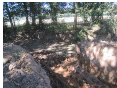
Creusement du nouveau lit (connexion amont)
