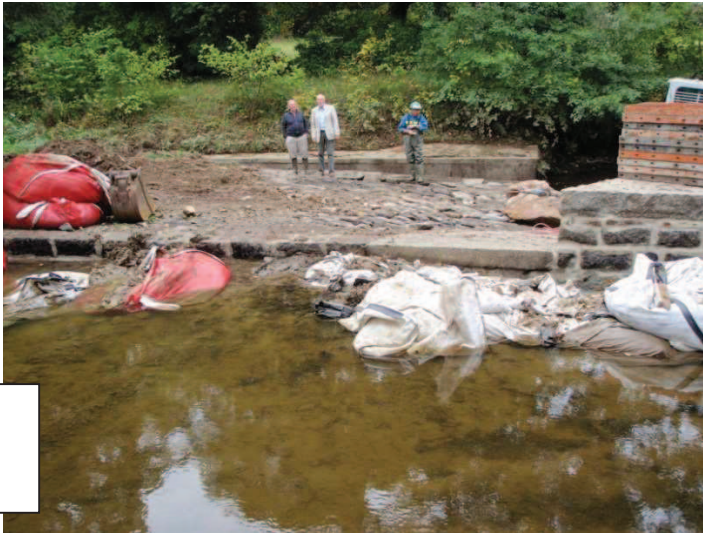
Début de restauration du déversoir
