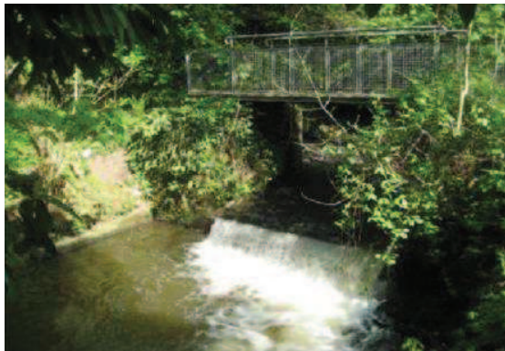
Le Moulin aux Pauvres avant travaux.
