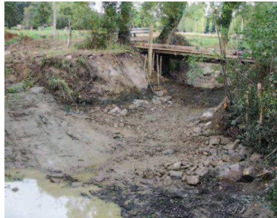
Le Moulin de la Marche pendant les travaux.
