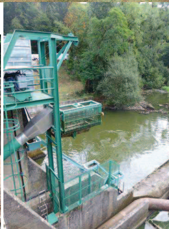
Passé à anguilles, dispositif de piégeage et ascenseur après travaux (Source : Eau du Morbihan)
