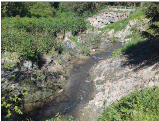
Cours d'eau en amont de l'ouvrage après travaux
