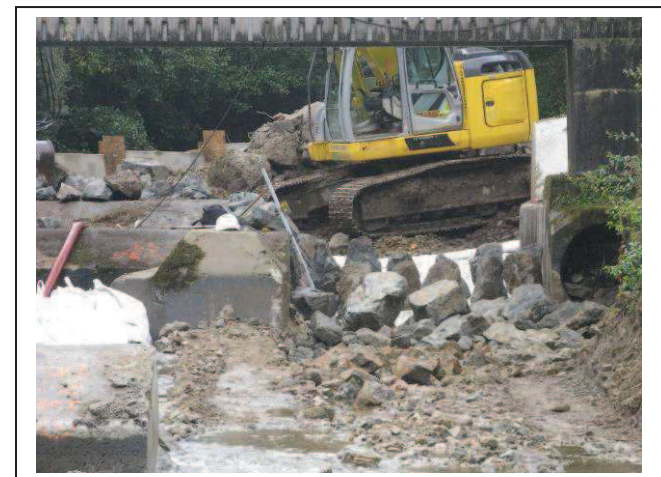
Mise en place des blocs dans la future passe. Une double pente est prévue pour chaque rampe (amont-aval et rive gauche vers rive droite)
