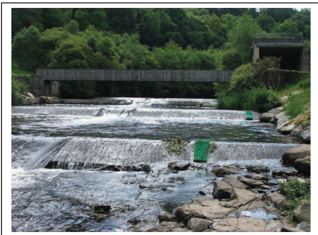
4 seuils avec une échancrure centrale. Et tapis à anguilles à sec à l'étiage
