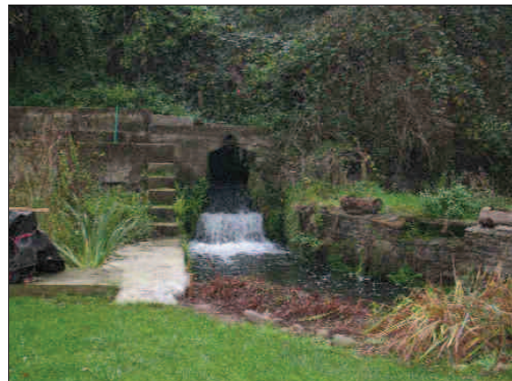
Cours d'eau en aval de l'ouvrage avant travaux
