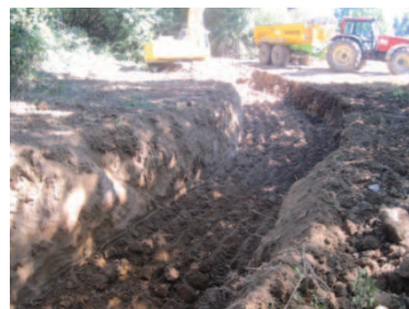
Creusement du nouveau lit en rive droite
