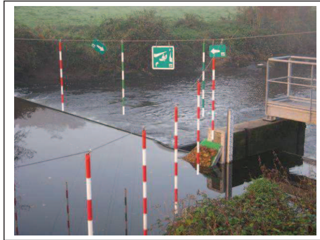
Mise en place d'indications kayaks, d'une échelle limnimétrique et d'une passerelle pour l'entretien de la passe.
