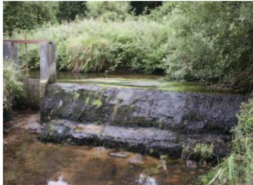
Seuil du Moulin de Trémillec avant travaux
