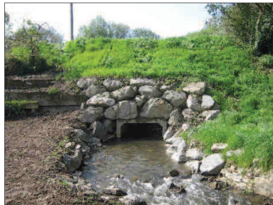
Cours d'eau en aval de l'ouvrage après travaux
