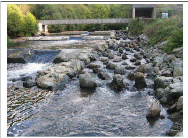
Aval des ouvrages à l'étiage
