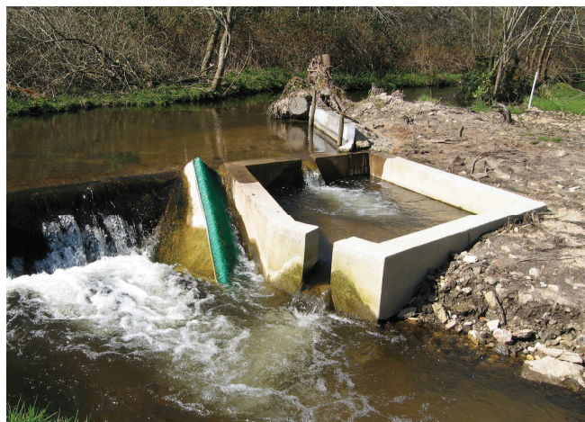
Vue de la passe à bassins et de la passe à anguilles
