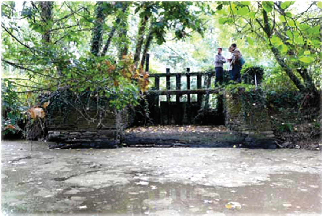
Après travaux vanne n°1 suppression des parties mobiles en bois :
