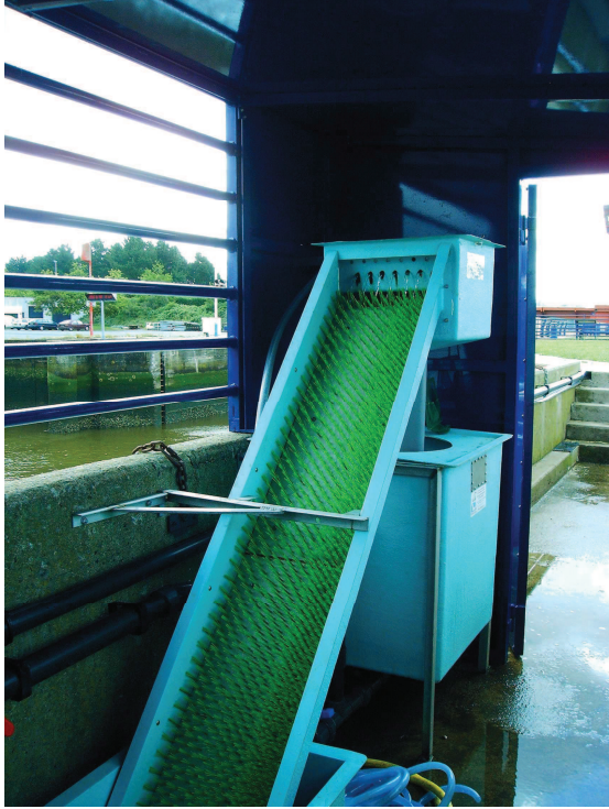
Photos 3 et 4.- Passe à anguilles avec 2 rampes et un bac intermédiaire.
