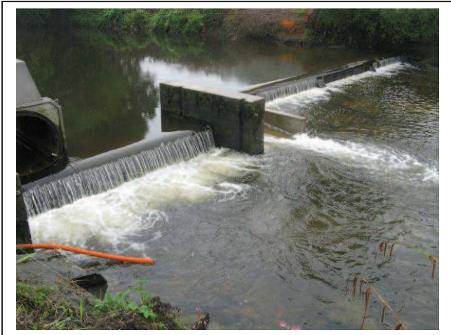
Remise en eau de l'ensemble de l'ouvrage.
