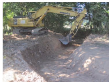
Reprofilage des berges et du fond du lit
