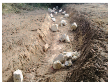
Diversification du nouveau lit par mise en place de blocs (épis/défecteurs, abris/caches, épars)
