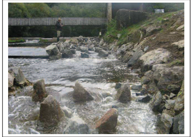
Mise en eau des passes
