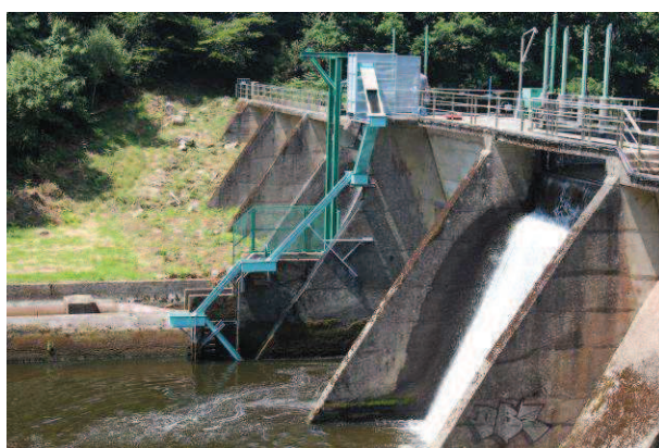
Passé à anguilles, dispositif de piégeage et ascenseur après travaux (Source : Eau du Morbihan)
