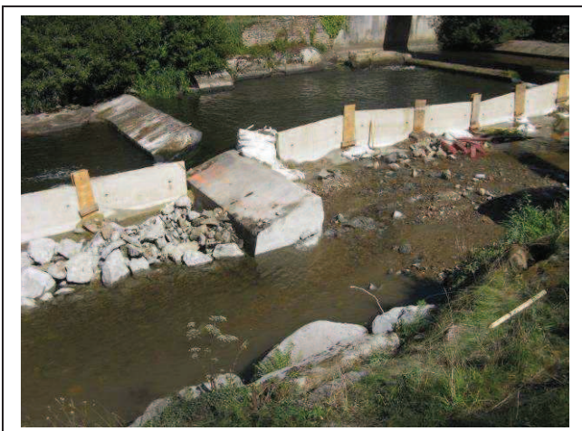
Mise en place des batardeaux et sciage des seuils pour implanter la rampe en enrochement
