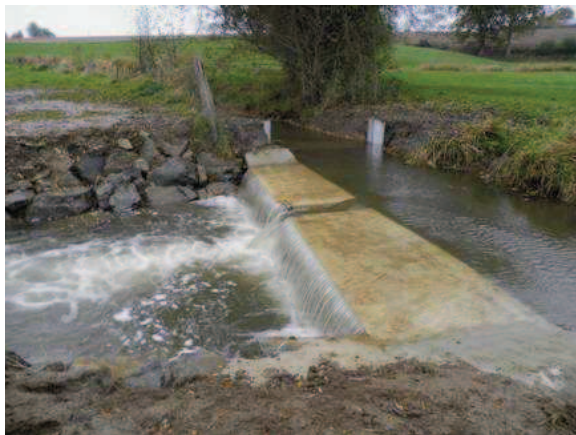
Le déversoir de la Motte après travaux : abaissement de 30 cm et création d'une échancre de 30 cm.
