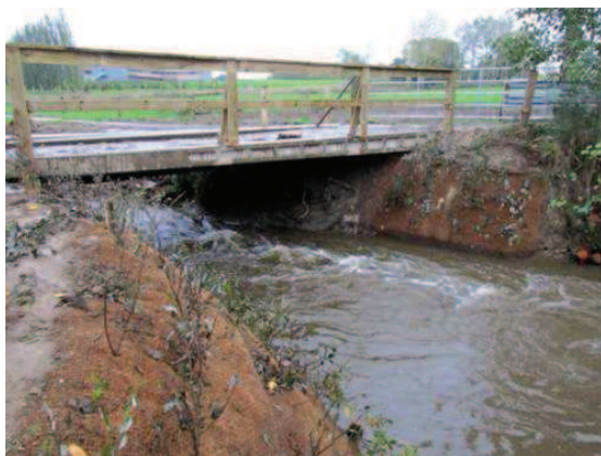
Le Moulin de la Marche juste après travaux.
