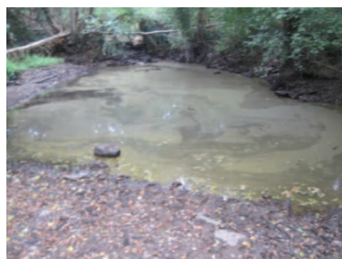
Vue sur fosse de dissipation du Moulin
