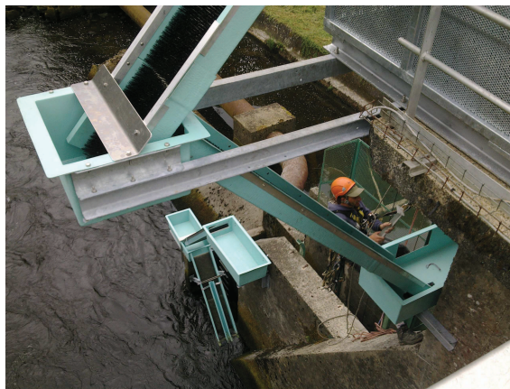
Barrage de Tréauray sur le Loc'h avant travaux ; installation des rampes à anguilles par cordistes (Source : Eau du Morbihan)
