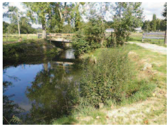
Le Moulin de la Marche 1 an après travaux.
