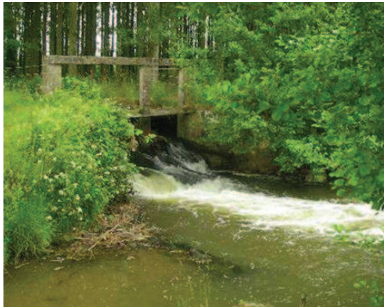
Le Moulin de la Marche avant travaux.
