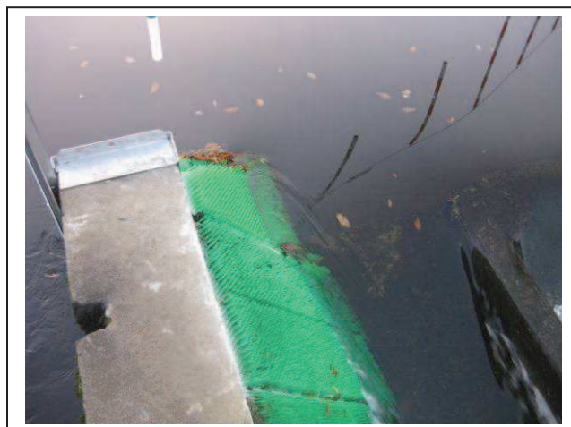
Tapis à anguilles qui dépasse le bord du seuil et permet l'accès au plan d'eau pour les civelles et anguilles.
