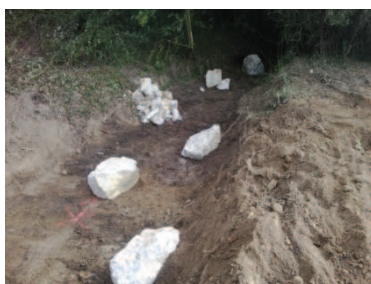
Diversification du nouveau lit par mise en place de blocs (épis/défecteurs, abris/caches, épars)
