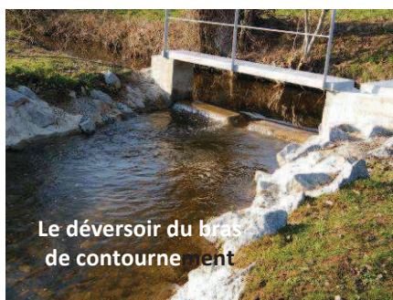
Echancrure dans mur du bief
