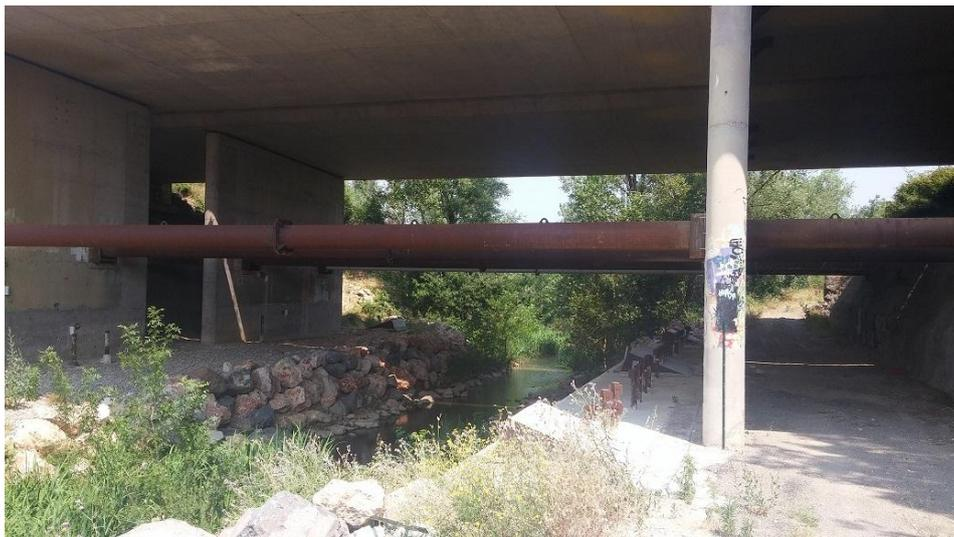
*Figure 10 : Exemple d'un passage fonctionnel pour la faune sous l'autoroute*
