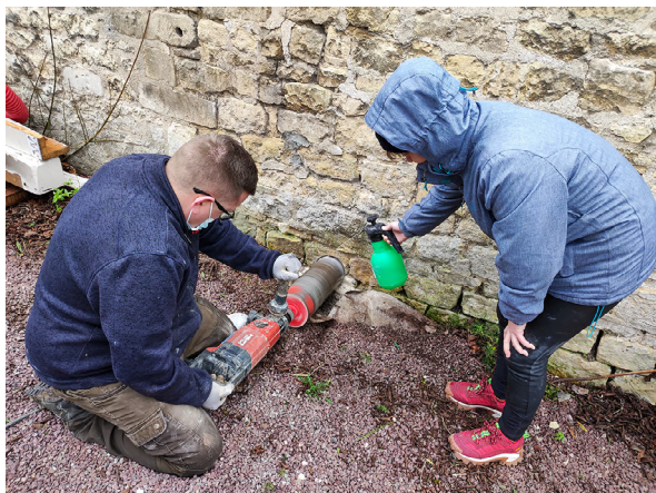
ill. 37. Carottage d'un trou de 15 cm de diamètre au pied d'un mur pour libérer un passage à hérissons. (photo : © Groupe Mammalogique Normand)
