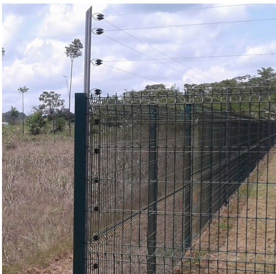
ill. 44. Une clôture électrifiée est ici plaquée à l'intérieur d'un grillage rigide et le dépasse en hauteur. (photo : © V. de Billy, OFB)
