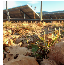
ill. 107. La garde au sol des grillages facilite le déplacement des animaux. (photos : C. Buton)
