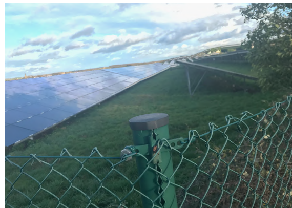
ill. 97. Exemple de grillage simple torsion avec des fils aboutés en partie haute et des poteaux capotés. (photo : C. Buton)
