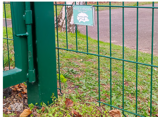
ill. 38. Passage découpé en pied de clôture rigide. Ici, la localisation dans un angle de clôture optimise le repérage par les animaux. Les fils coupés ne dépassent pas. (photo : © Groupe Mammalogique Normand)
