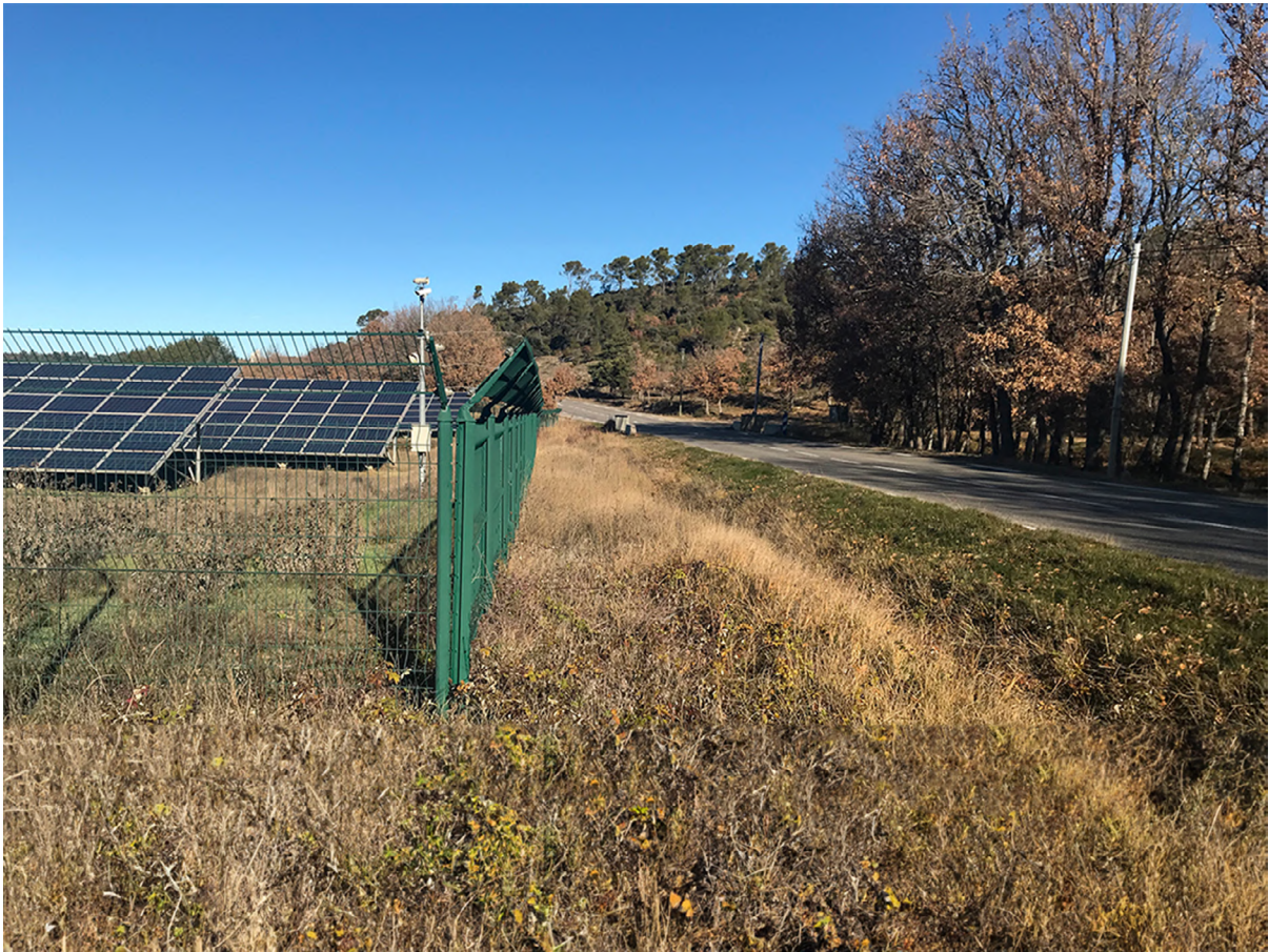
ill. 54. Exemple de CPV clôturée à proximité d'une route. (photo : C. Buton)
