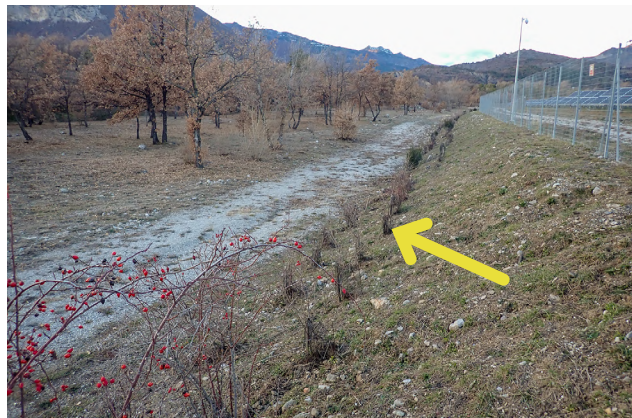
ill. 102. Plantation récente en périphérie de CPV. Au premier plan (flèche), des arbustes ont été plantés sur le remblai devant la clôture : ils devront se développer pour que la haie joue pleinement son rôle écologique. En arrière-plan, une bande OLD a été débroussaillée sur 50 m de large en conservant des arbres élagués, mis à distance les uns des autres. (photo : C. Buton)
