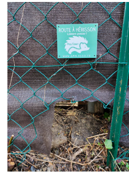
ill. 36. Exemple de passage découpé dans un grillage simple torsion. Les fils coupés ont été aboutés pour ne plus être dangereux. (photo : © Groupe Mammalogique Normand)
