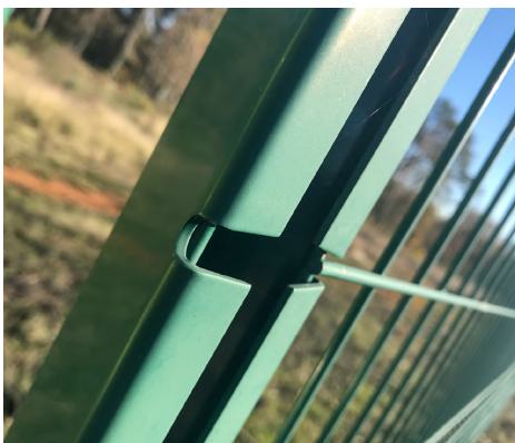
ill. 92. Exemple de poteau de section ouverte. Les poteaux de section ouverte sont a priori moins susceptibles d'attirer des espèces en quête de gîte et leur ouverture verticale laisse des possibilités de fuite
