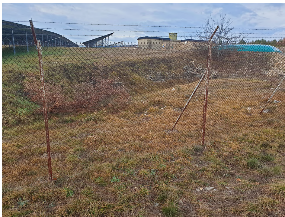
ill. 81. Ancien terrain militaire réaménagé en CPV. Le grillage simple torsion est surmonté d'un bavolet à trois rangs de barbelés. (Photo : © S. Foli, Auddicé Environnement)
