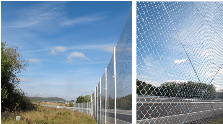
ill. 25. Exemple de grillage utilisé aux abords d'infrastructures de transport pour préserver spécifiquement les chiroptères.
