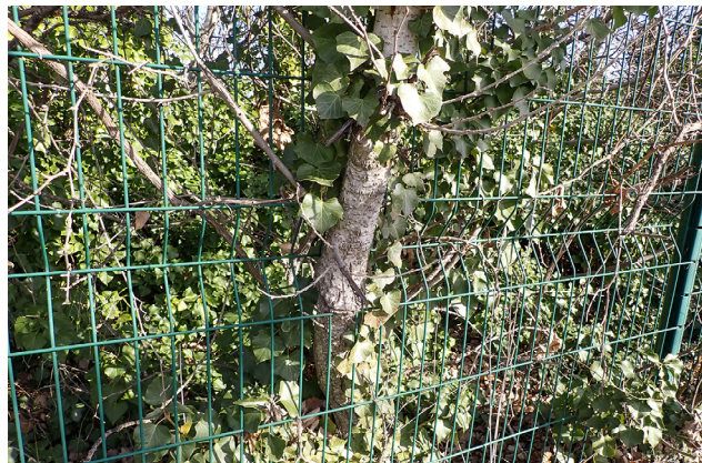
ill. 103. Végétation se développant dans la clôture. La végétation ligneuse qui se développe directement dans les mailles de la clôture (ici, peupliers et lierre) peut l'endommager, complique sa surveillance et complexifie la dépose en fin d'exploitation. (photo prise hors contexte CPV : C. Buton)
