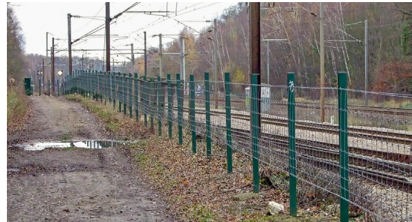
ill. 63. Exemple de clôtures perméables à la faune. Les clôtures installées aux abords de la voie ferrée à Orry la Ville sécurisent les promeneurs qui empruntent les chemins forestiers tout en restant perméables à la faune. (photo : © OGE - V. Vignon)
