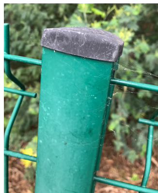
ill. 93. Certains capots simplement emboîtés peuvent s'arracher.
