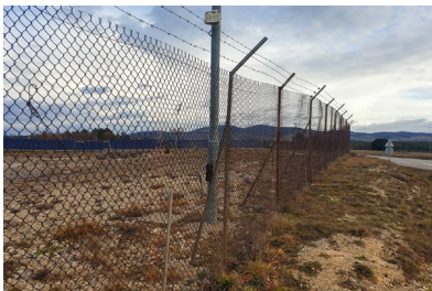
ill. 39. Exemple de barbelés constituant un bavolet sur la clôture d'un ancien terrain militaire réaménagé en CPV. (photo : © S. Foli, Auddicé Environnement)
