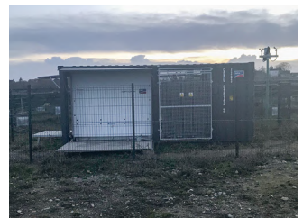
ill. 72. Local technique dans une seconde clôture incluse au sein de la clôture périmétrale générale.
