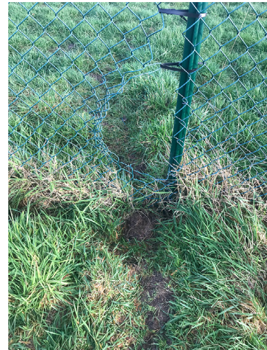
ill. 46. Nombreuses traces de passages d'animaux au pied et dans la partie basse d'une clôture de CPV. (photo : C. Buton)
