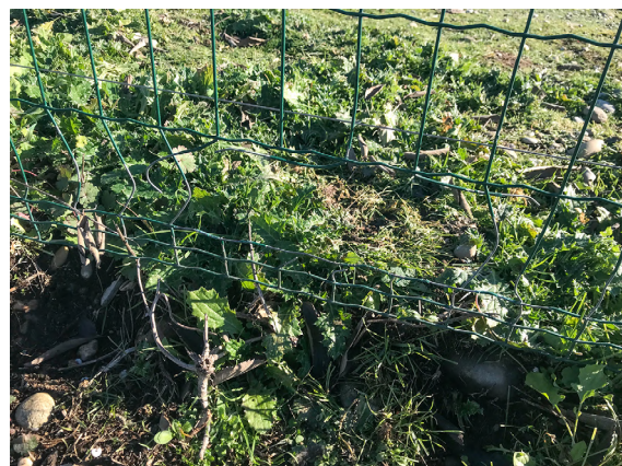
ill. 65. Clôture souple endommagée lors du fauchage à la débroussailleuse à dos. A terme, la vétusté de la clôture est susceptible d'entraîner son remplacement par un autre matériel qui n'aura pas été évalué au titre de l'Étude d'Impact. Pour mémoire, des fils coupés peuvent blesser des animaux. (photo : C. Buton)
