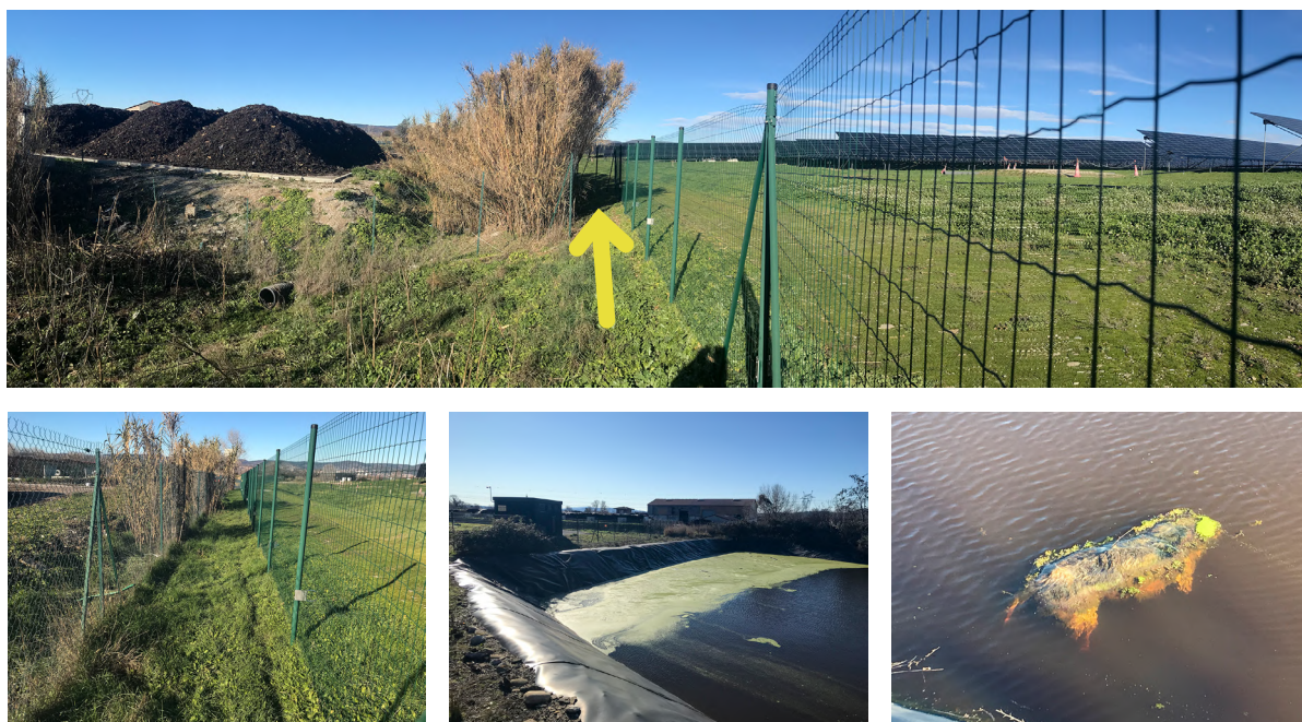
ill. 53. Exemple de couloir grillagé conduisant de fait les animaux vers un bassin technique.
