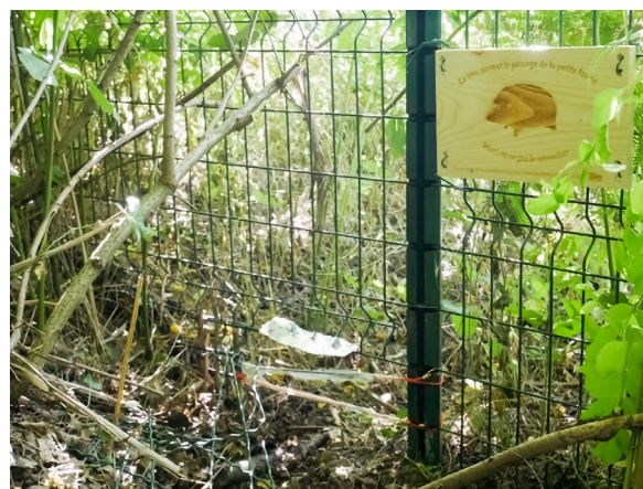
ill. 123. Passage à faune découpé en pied de clôture rigide avec sa plaquette informative et son système de collecte de poils.
