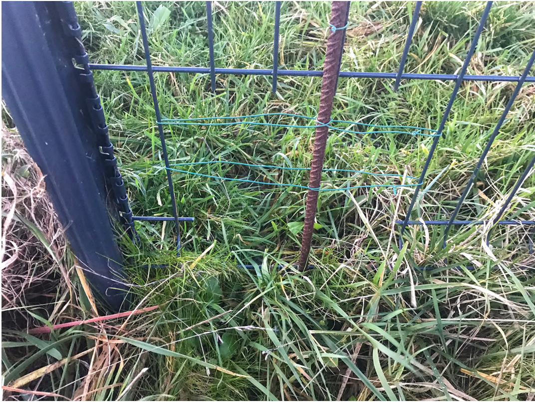
ill. 78. Fermeture d'une découpe de grillage rigide qui était potentiellement utilisable par la faune sauvage. (photo C. Buton)
