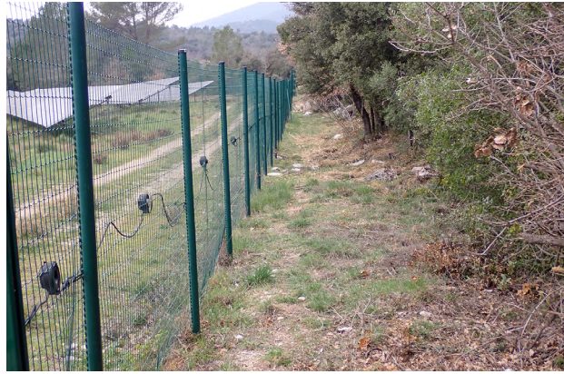
ill. 101. Chemin de visite dégagé entre une haie et la clôture. (photo : C. Buton)
