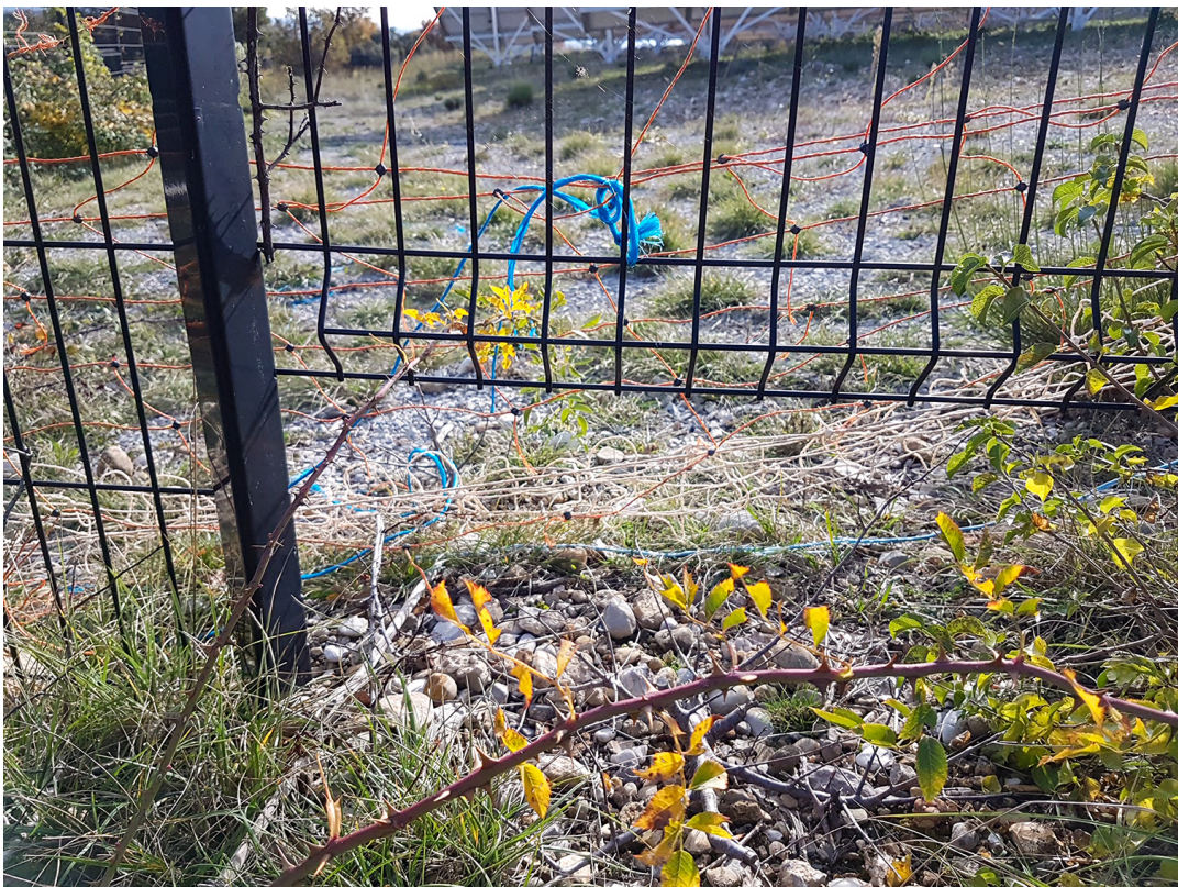
ill. 79. Filet souple colmatant un espace sous le grillage. (photo © Auddicé Environnement)
