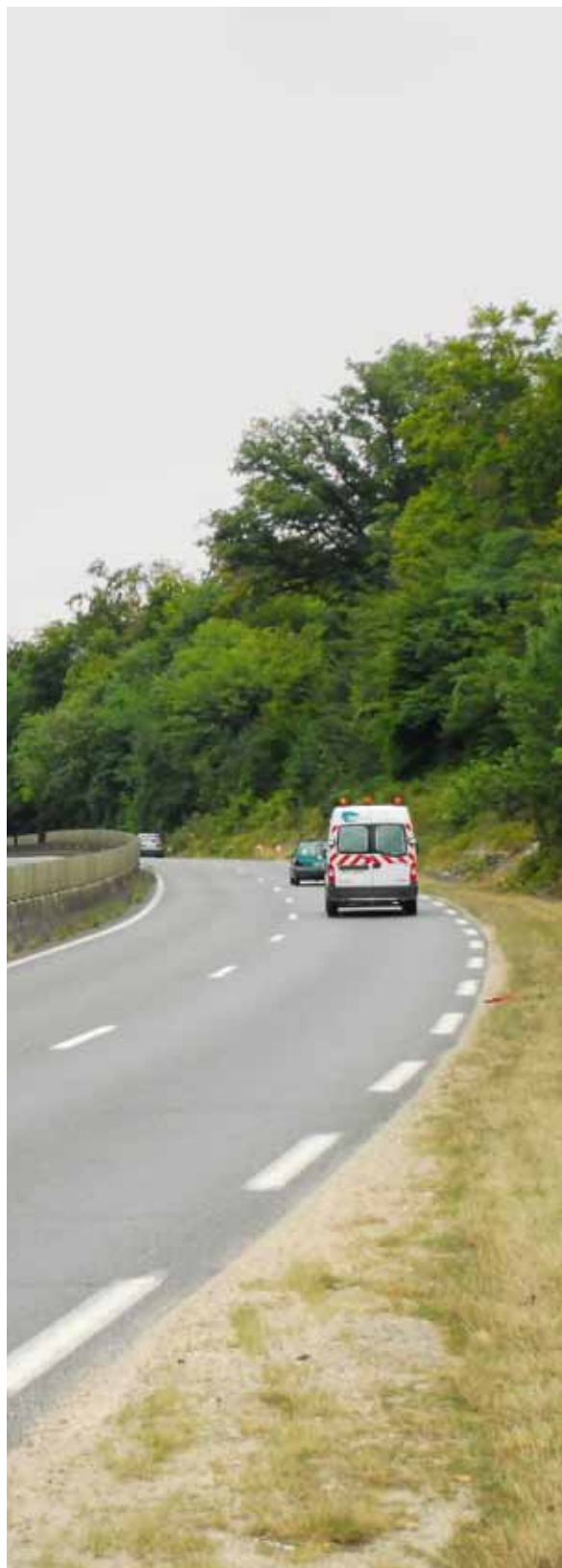
Une infrastructure fractionnante n'est pas nécessairement une autoroute ou une ligne à grande vitesse. La conjonction d'un trafic élevé et de barrières séparant les chaussées suffisent à rendre l'infrastructure imperméable à la faune. © M. Zucca
