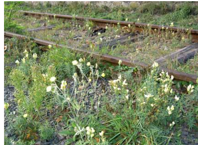
Un ancien ballast en cours de recolonisation
