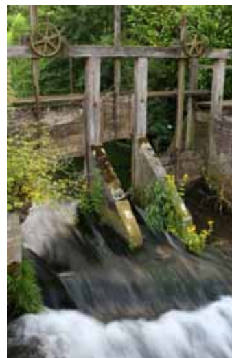
Les ouvrages hydrauliques (ici sur l'Aa), des obstacles pour les poissons migrateurs
