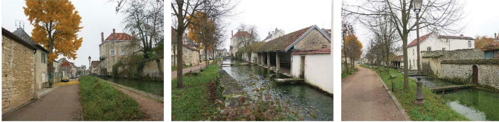
Bief des Courtines : Rue Gambetta
