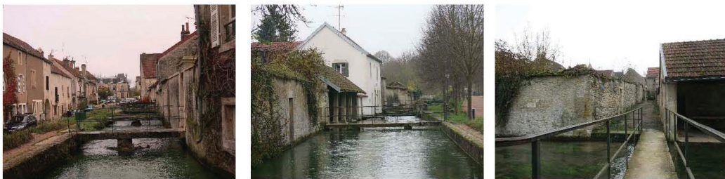
Bief des Courtines : Rue Gambetta
