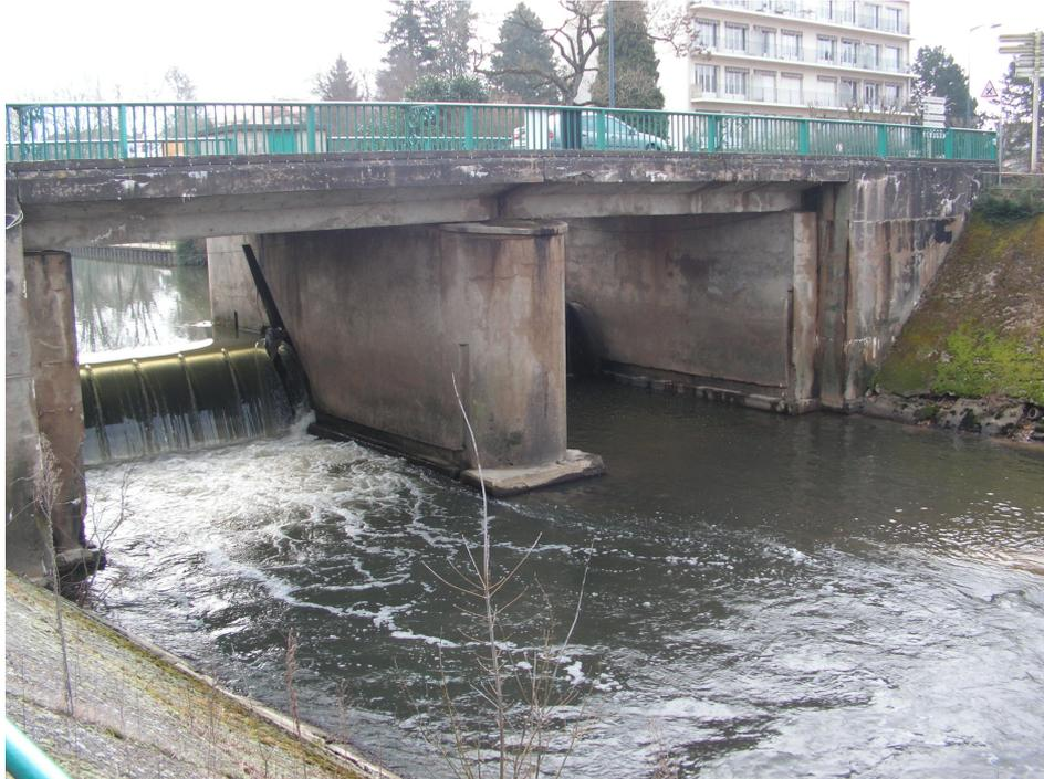
**Photo 1 : seuil de Paray-le-Monial (71). La configuration des lieux n'est pas propice au contournement de l'ouvrage par les berges. Cependant, un indice de présence probable en amont de celui-ci montre que le seuil peut être franchi sous certaines conditions (crues par exemple).**
