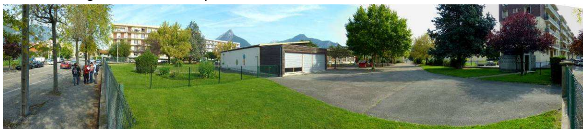
Rue Lénine, vue sur l'école : des grilles cloisonnent la surface verte en plusieurs espaces.
