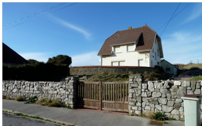
Maison avant travaux à Wimereux © G. Lemoine - EPF
