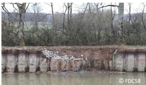
*Figure 2 : Enrochement de la zone ouverte*
