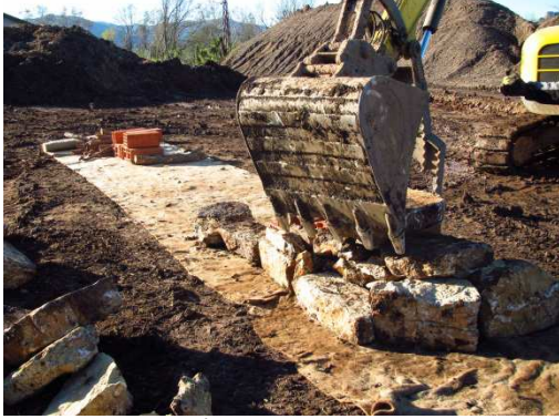
photo 12. Calage à la pelle des dalles de couverture
