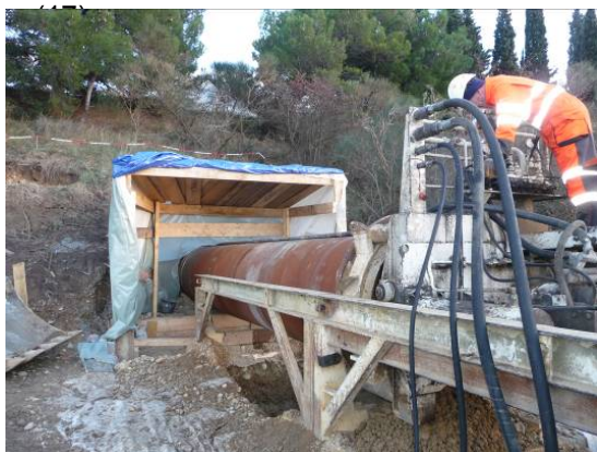
Fonçage d'une buse en Ø1200mm A7 (26)
