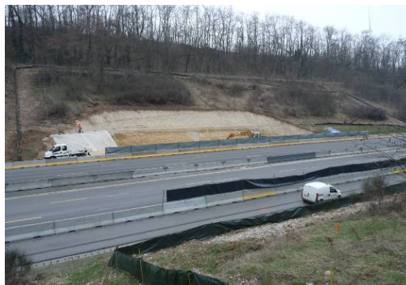
Terrassement du futur chantier d'éco-pont A7 (26)
