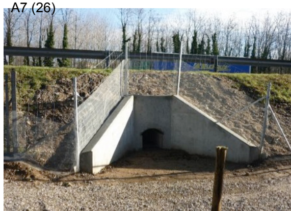
Fonçage de buse Ø800 mm achevé sur A7 (26)
