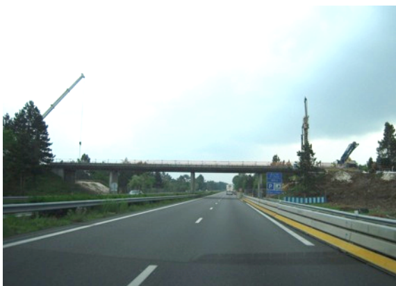
Transformation d'un PGF en éco-pont A10
