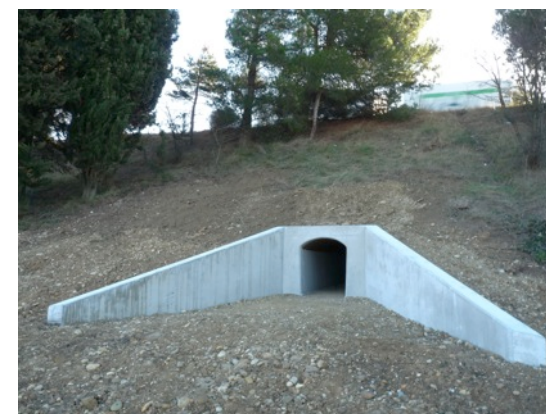
Finition des têtes de la buse Ø1200mm A7 (26)
