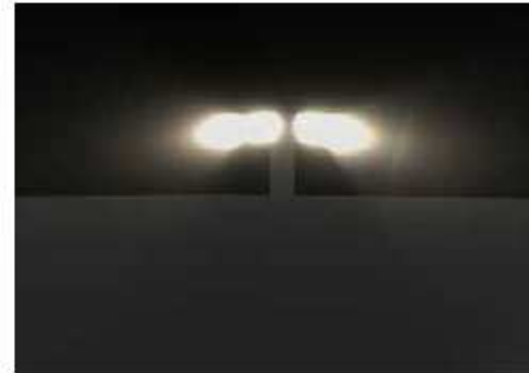
AVANT : Projecteurs équipés de "paralumes" sur mât de grande hauteur avant rénovation - puissance installée initiale : 12 kW.
