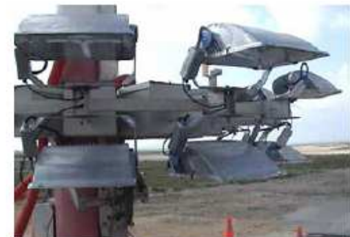
APRES : Projecteurs asymétriques sur mât de grande hauteur après rénovation - puissance installée : 6 kW (-50%) - taux ULOR 0%.
