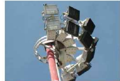
AVANT : Projecteurs équipés de "paralumes" sur mât de grande hauteur avant rénovation - puissance installée initiale : 12 kW.
