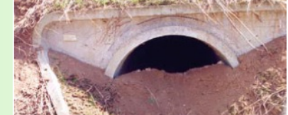
Buse colmatée par l'érosion
