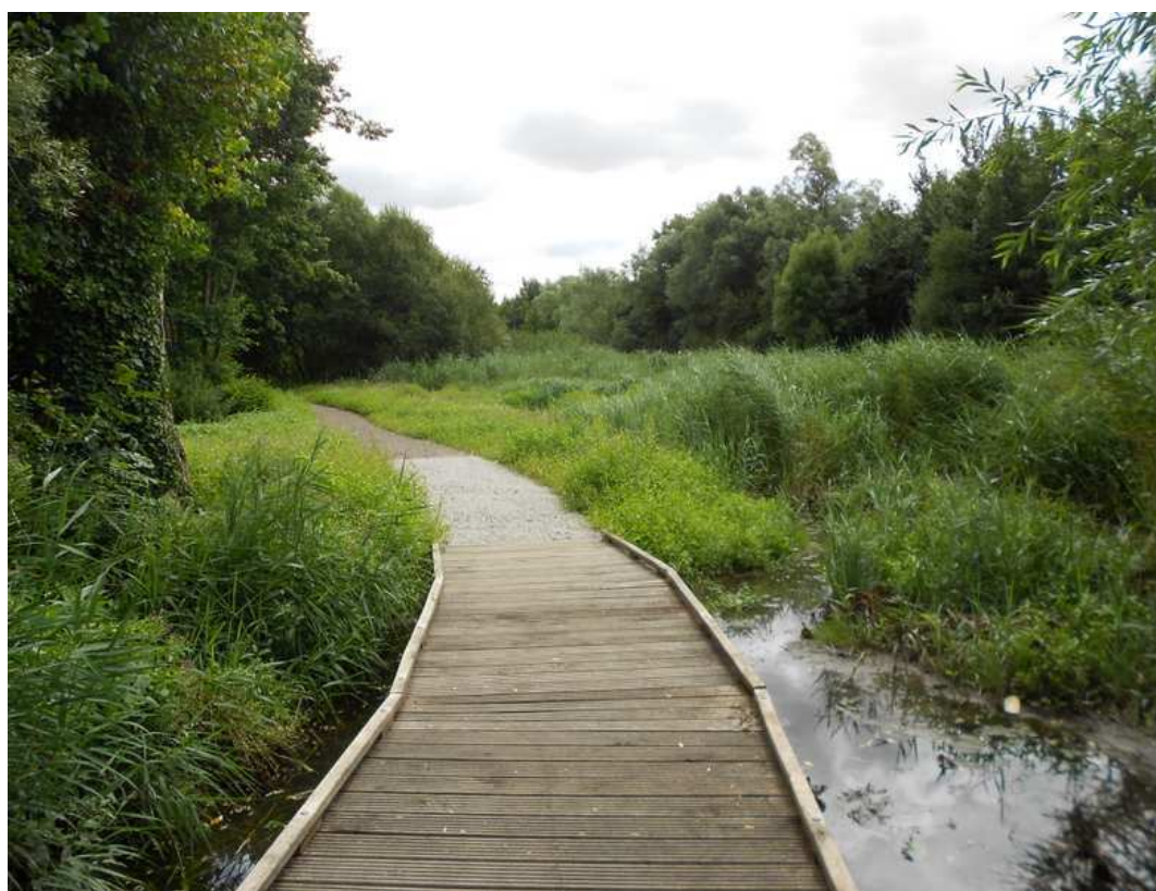
L'ouvrage terminé, le site a cicatrisé en moins d'une saison
