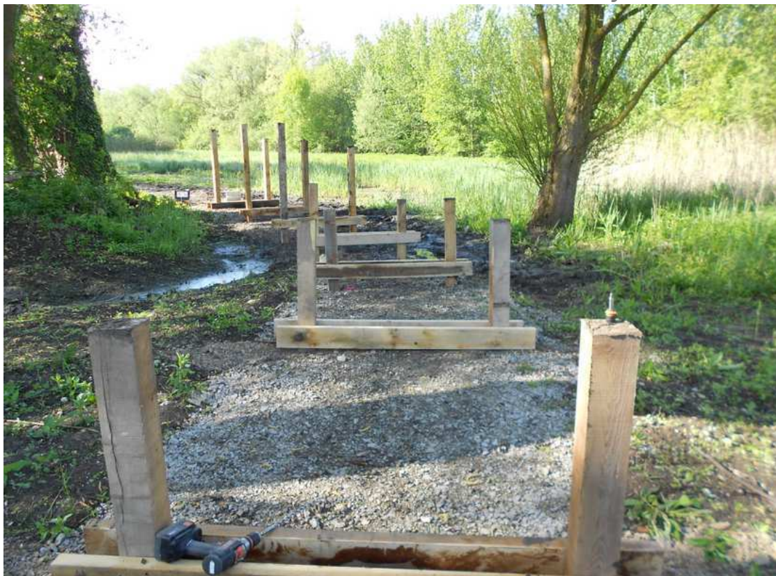
Pose de caillebotis pour franchir les espaces marécageux
