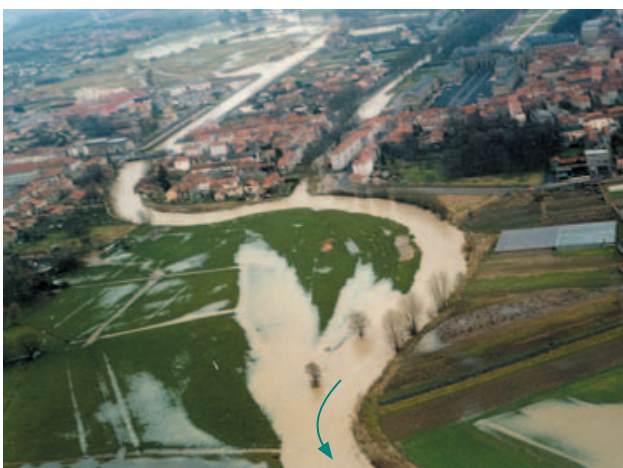
La Vezouze à Lunéville avant les travaux de restauration. La digue en rive gauche empêche l'expansion des crues dans le lit majeur.
