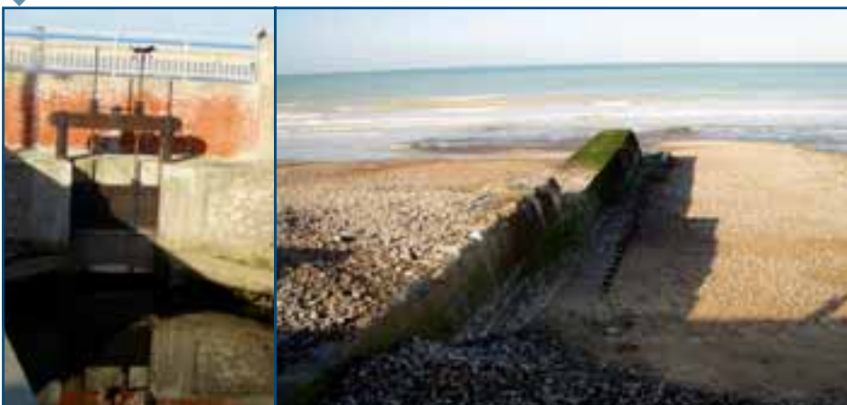
↓ Figure 47 : Clapet et busage sur l'exutoire de la Scie (76). ≍
