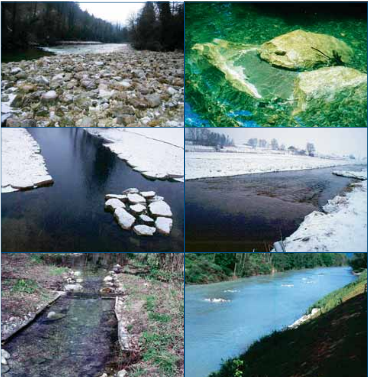
↑ Figure 8 : Différents exemples d'aménagements essentiellement piscicoles : en haut à gauche risberme en enrochements sur la Bienne (39), en haut à droite agencement de blocs sur la Savoureuse (90), au centre amas de blocs et radier artificiel sur le Drugeon (25), en bas à gauche caches artificielles sur un petit ruisseau affluent de l'Allondon (Suisse, canton de Genève) et en bas à droite aménagements piscicoles sur l'Arve (74). ≍
