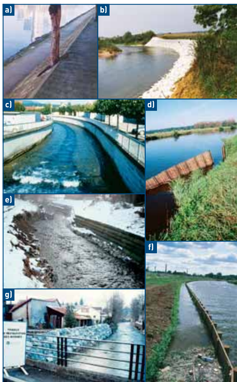
Figure 29 : a) Perrés en milieu urbain. b) Enrochement de berge en secteur agricole. c) Murs en traversée urbaine. d) Palplanches en protection de berge de rivière naviguée. e) Palissade en rondins de bois. f) Technique des « tunages-bois » en protection de berges de voies navigables. g) Sans commentaire !
