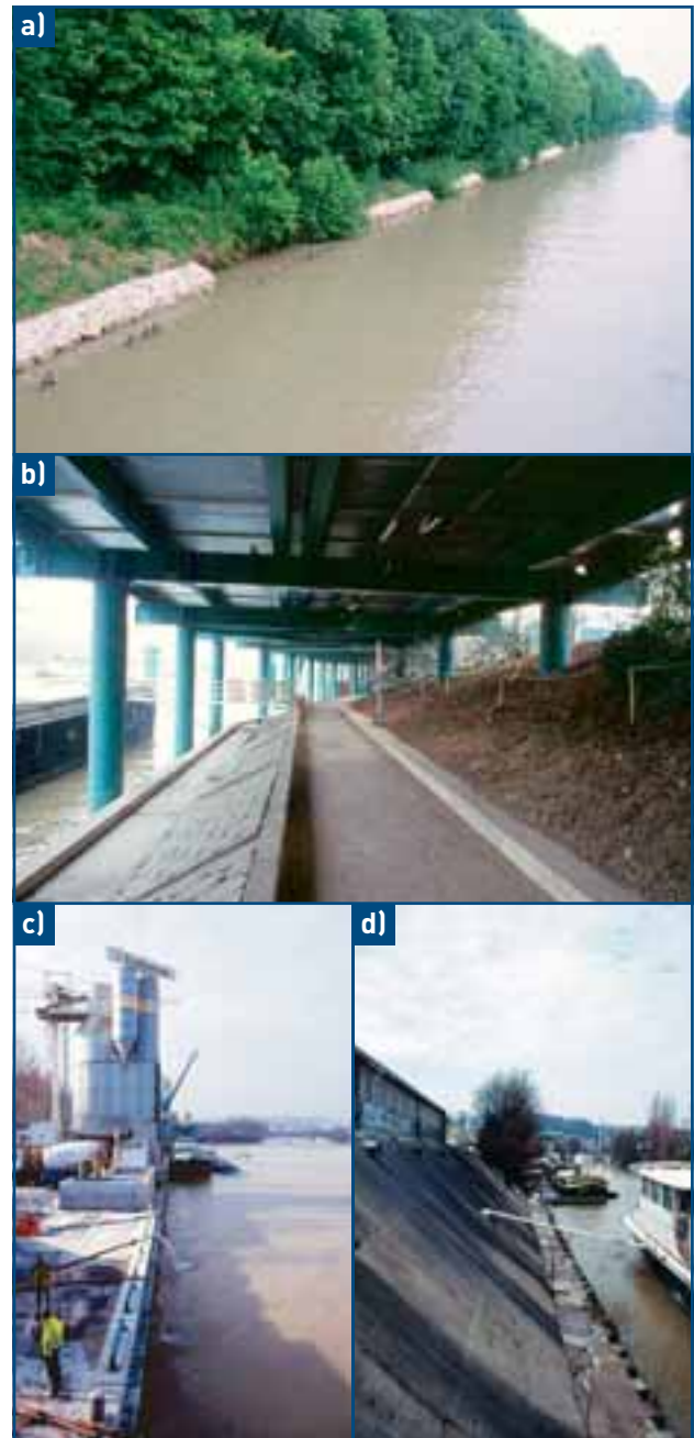
Figure 42 : Quelques exemples d'aménagements et d'usages particuliers des voies navigables : a) Canal de dérivation de la Marne et berges artificielles. b) Infrastructures routières et berges minéralisées en bordure de Seine naviguée. c) Quai de chargement en bordure de Seine. d) Bateaux « logement » et berge artificielle en bordure de Seine. ≈
