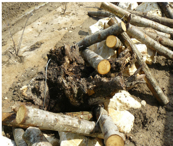
Photographie 3 : Détail de l'andain (pierres, souches et rondins de bois reliés ensemble – A10 DTer SO)
