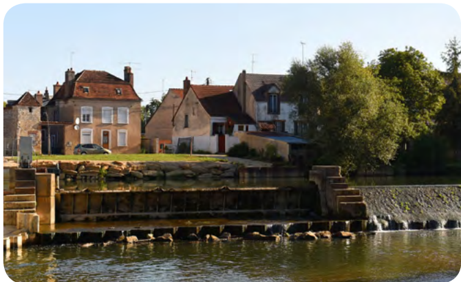
► Clapet de décharge et chasse des sédiments - Briénon-sur-Armançon (89)
