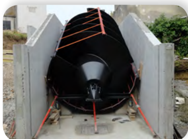
► Vis hydrodynamique en phase travaux Champdôtre (21)
