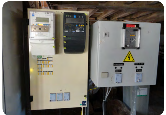
▶ Compteurs et coffret de découplage réseau – Moulin de Tart-l'Abbaye (21)
