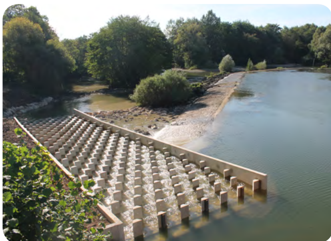
► Rampe rustique à enrochement - Ouvrage de Voray (70)
