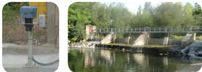
► Sonde de niveau et vannes au barrage - Moulin de Champdôtre (21)
