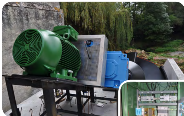
▲ Vis hydrodynamique - Champdôtre (21) → générateur en vert et multiplicateur en bleu
