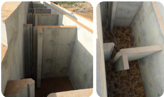
► Passe à poissons - Briénon-sur-Armançon (89)
