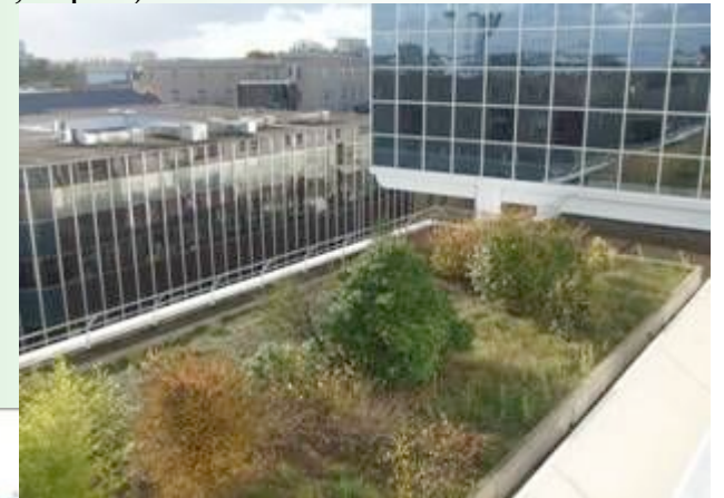
Toiture végétalisée CHU Rennes (F)
