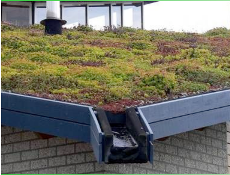
Toiture végétalisée Culemborg (NL)
