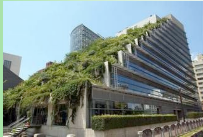
Bâtiment végétalisé (Fukuoka, Japon)
